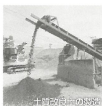
土質改良土の製造
